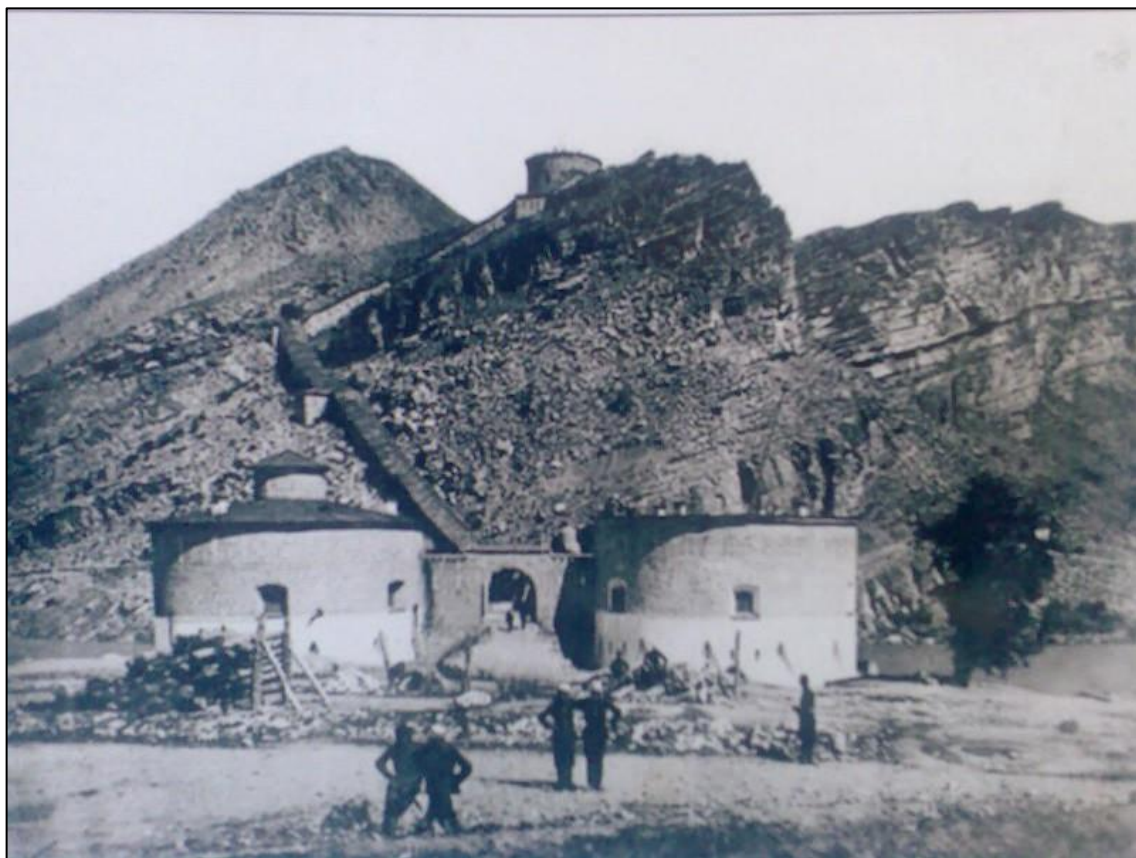
Архивное фото № 1. Общий вид на Преображенское укрепление (редут) на дату строительства, 1867 год
